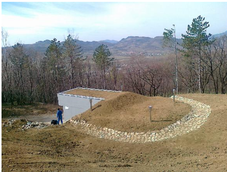
Novozgrajeni vodohram Gradišče pri Vipavi
