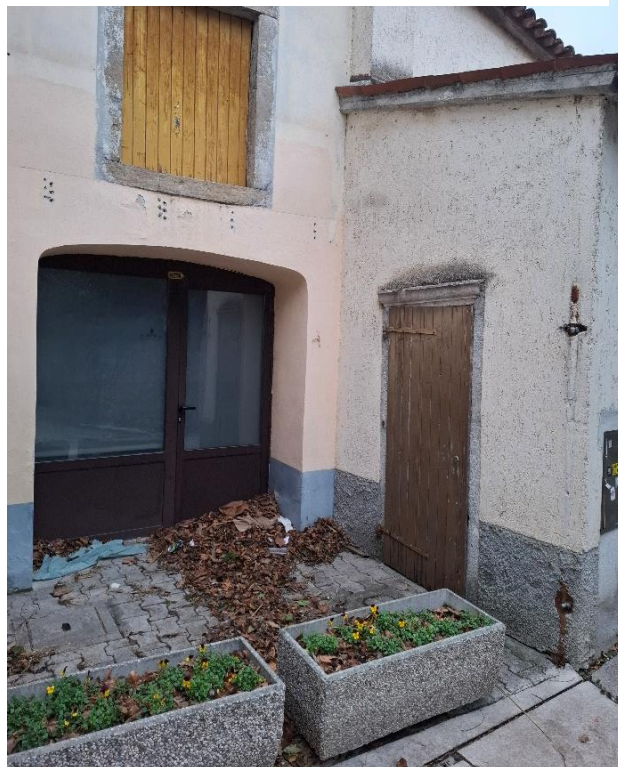
Slika 3-3: Pročelje povezanega objekta z razvidno navezavo na objekt Prešernova ul. 7a
