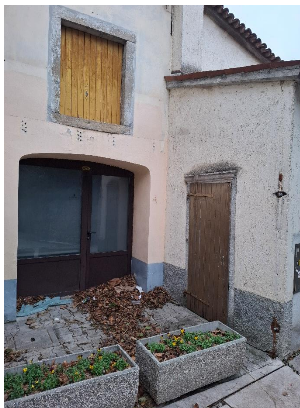
Slika 4-1: Pročelje povezanega objekta z razvidno navezavo na objekt Prešernova ul. 7a
