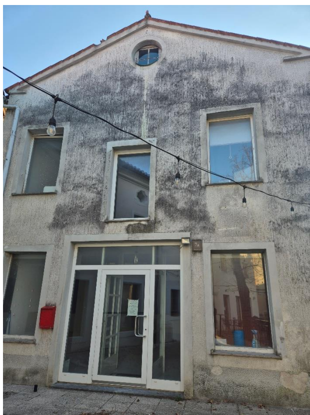
Slika 4-2: Pročelje objekta Prešernova ul. 7a
