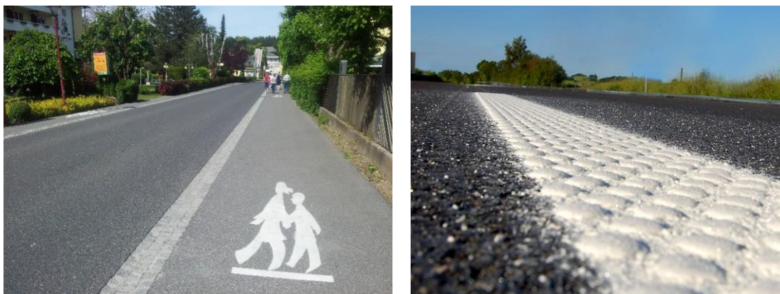
Slika A: Pas za pešce s taktilno zaznavnim robom iz granitnih kock. Slika B: Taktilna ločilna črta iz materialov za debeloslojne označbe.
