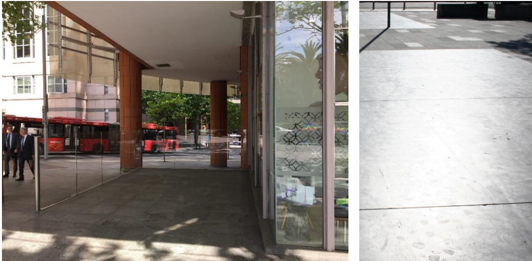
Slika A: Steklena ograja, ki jo uporabnik z okvaro vida ne more opaziti. Slika B: Pri izbiri tlakov se izogibamo bleščečim, močno odsevnim tlakom, ki zelo poslabšajo vidno zaznavo.
